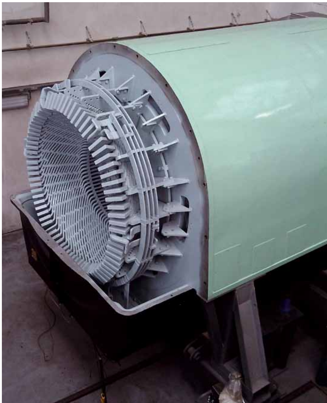
Stator turbogenerátoru 57 MW po opravě
